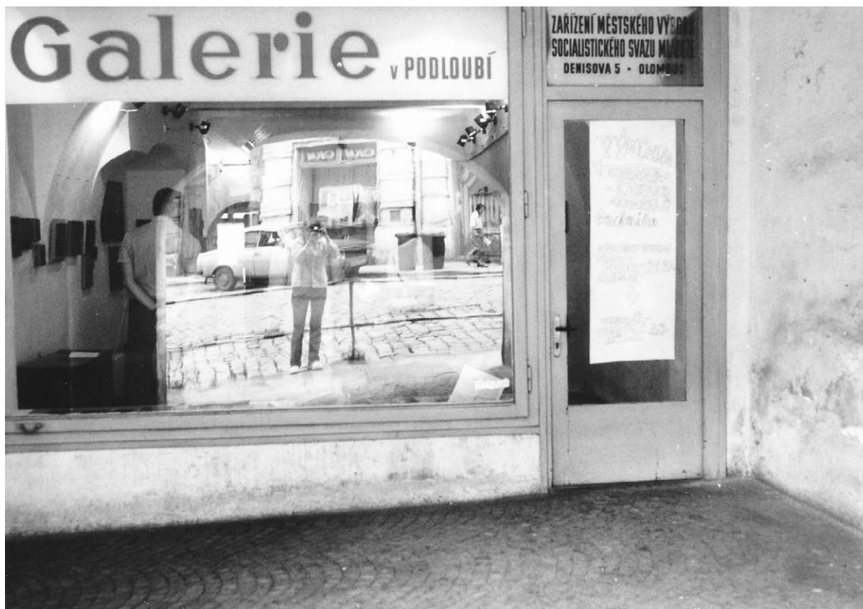
pohled na vstup do galerie, archiv manželů Škvařilových
