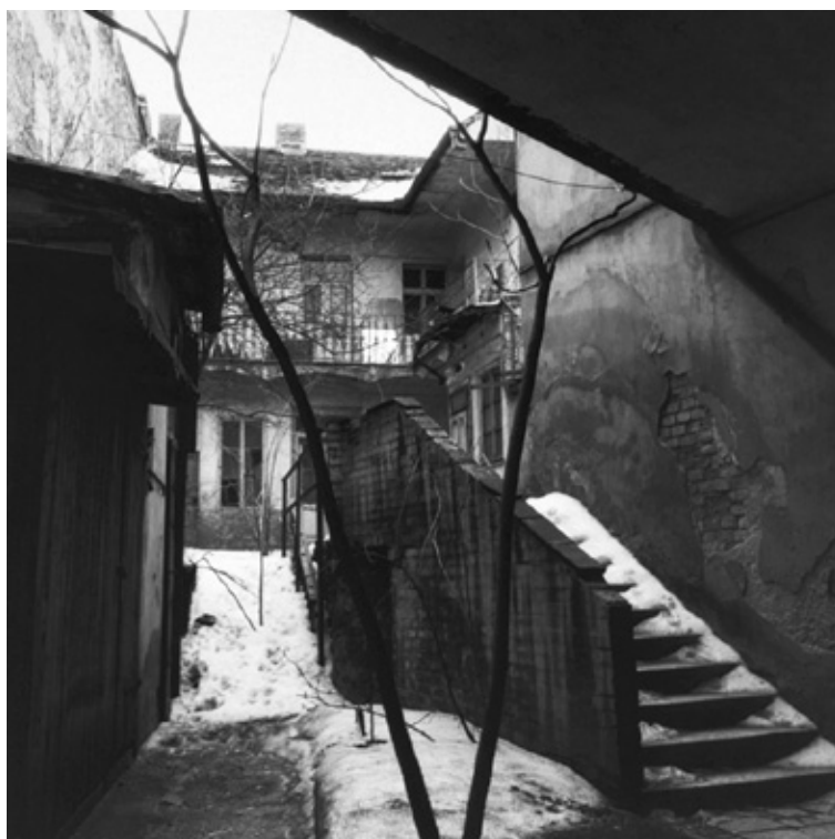
Dvorní trakt domu č. 24 v ulici Na hrázi v Praze-Libni, proslulá Hrabalova „Hráz věčnosti“. 1987
