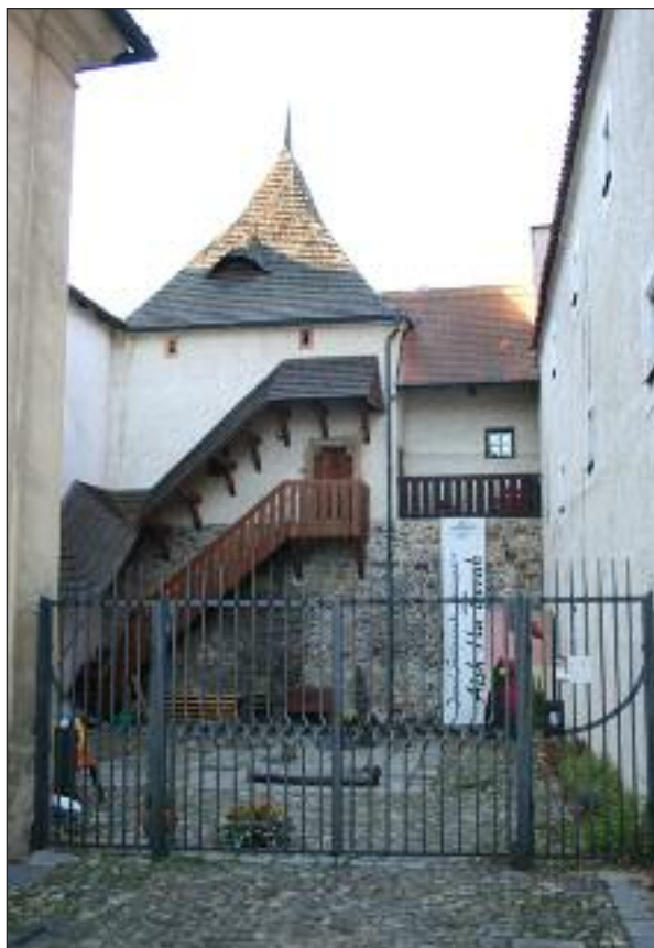
Galerie Pod kamennou žábou
