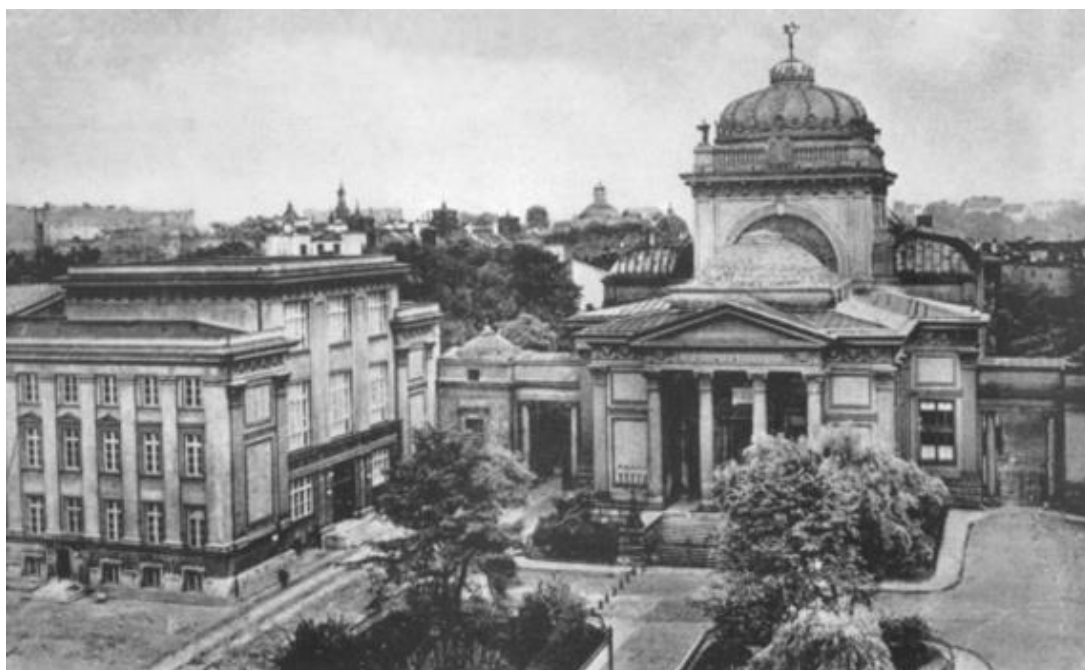
Budova Hlavní judaistické knihovny a Velká synagoga na Tłomackiem
