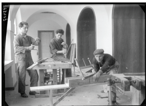
Archív SNG, Základné adaptačné práce v novopride- lenej budove Vodných kasární. 1951
