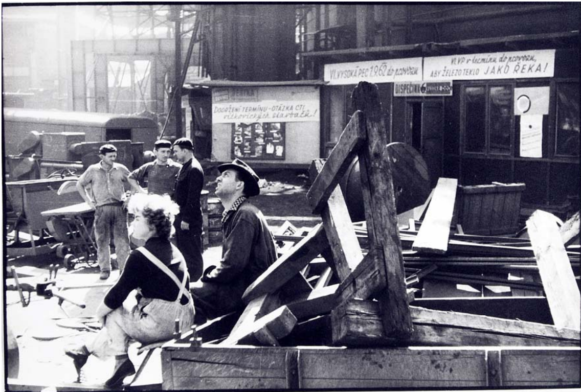
Stavba šesté vysoké pece, Ostrava 1962
