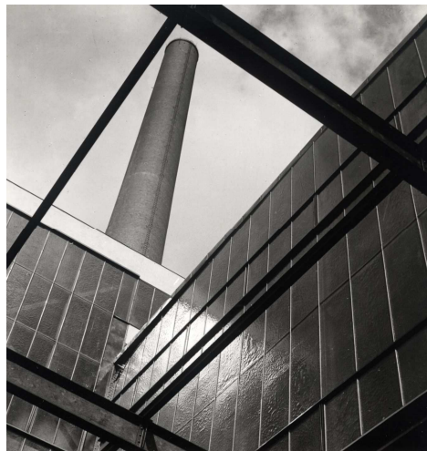
J. Funke, Elektrárna ESSO, 1932
