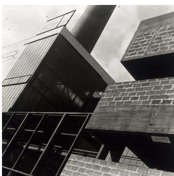
J. Funke, Elektrárna ESSO, 1929 - 32
