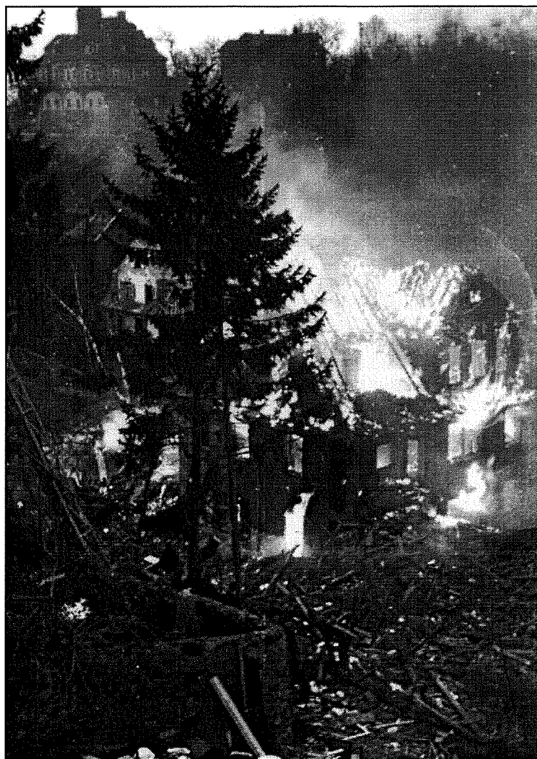
Wetzlar z jara v roce 1945 Haus F. Neumann, krátce po bombardování (historický archiv Wetzlar).
