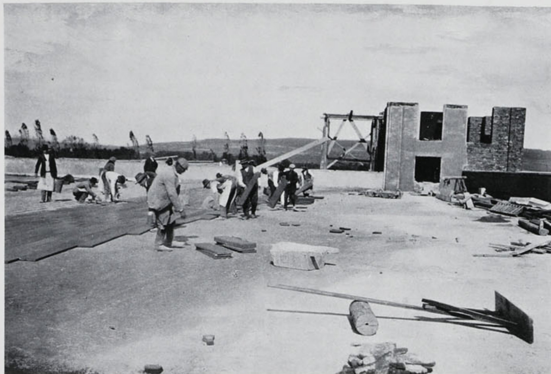
ISOLACE STOPU Z ARMOVANÉHO BETONU V ROZMĚRU 7000 m 2 KORKOVÝMI ISOLAČNÍMI DESKAMI V NOVÉ PŘÁDELNĚ A TKALCOVNĚ FIRMY JAN HERNÝCH A SYN V DOUDLEBÍCH.
