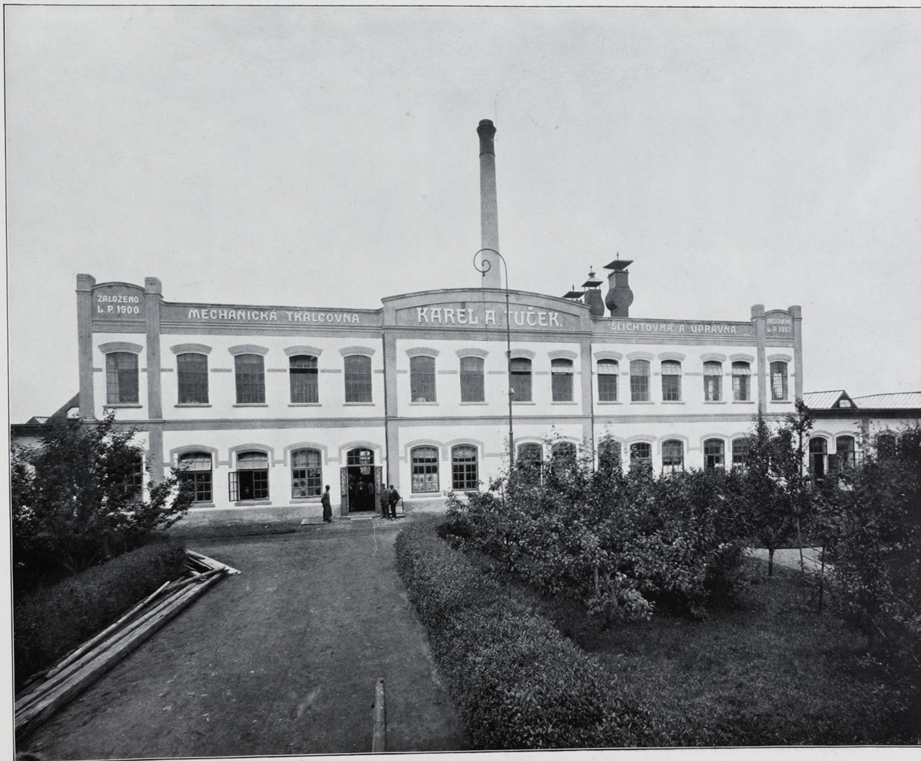
POHLED NA STŘED BUDOVY TKALCOVNY V HOŘICÍCH.
