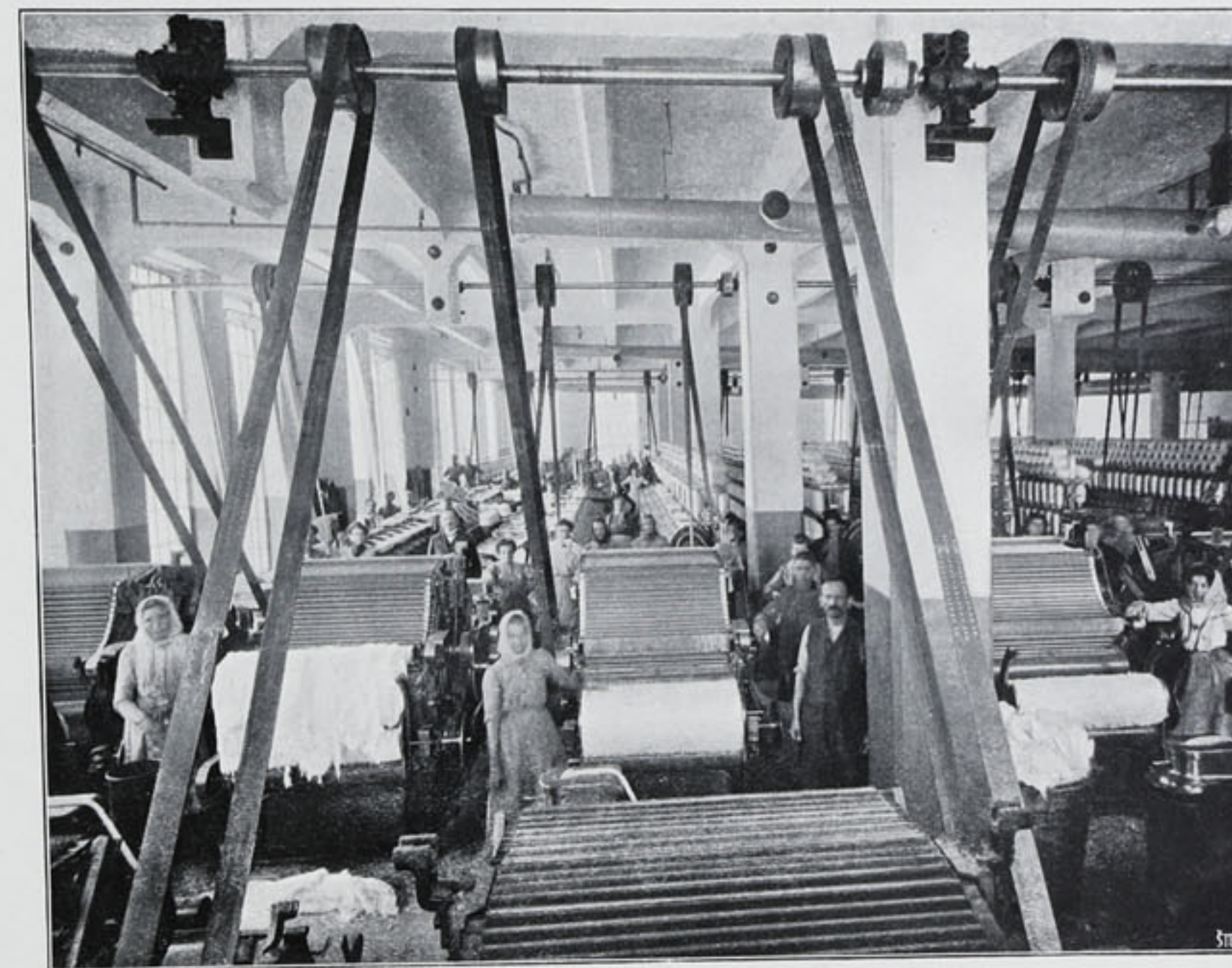
SÁL STROJŮ MYKACÍCH, ČESACÍCH A PŘEDPŘÁDACÍCH.
