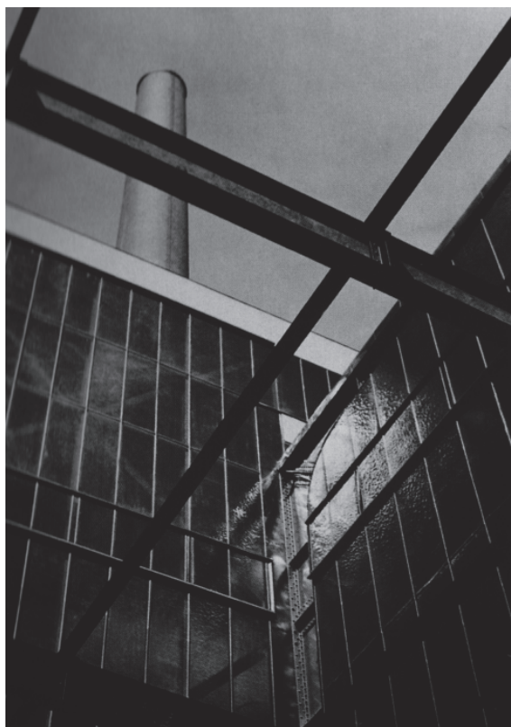
Jaromír Funke: Elektrárna v Kolíně, 1932
