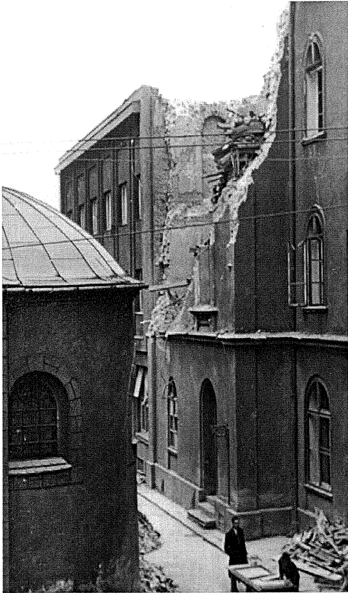
Budova učňovské školy po náletu v září 1944 (Kostelní náměstí 1). Vlevo kostel sv.Václava. Dnes v těchto místech stojí nová budova Ostravsko-opavského arcibiskupství (f/1)
