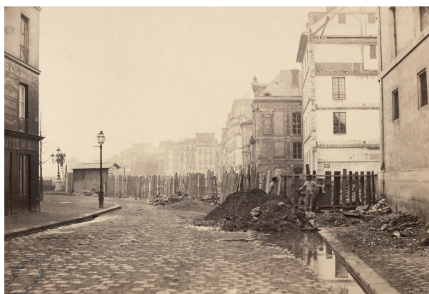
Rue du Sully, Charles Marville, 1876
