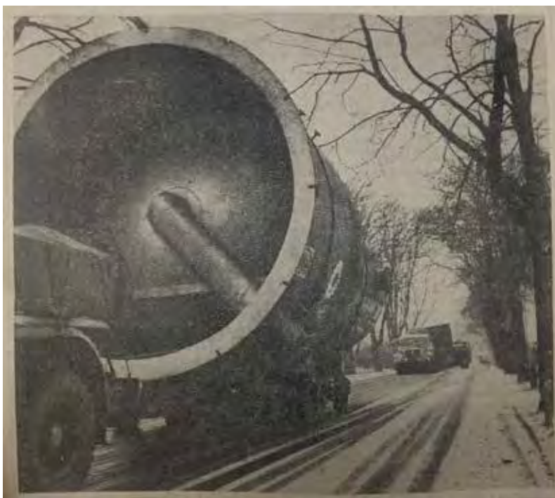
OBR. 3. DENÍK TRYBUNA LUDU , 27. LEDNA 1968, POPISEK SNÍMKU: „Z BRNĚNSKÉHO PODNIKU HEPOS, VYRÁBĚJÍCÍHO CHEMICKÁ ZAŘÍZENÍ, KDE BYLY VYROBENY SOUČÁSTI ZAŘÍZENÍ PRO ROPNOU RAFINERII V SÝRII, PROBÍHÁ TRANSPORT TĚCHTO ZAŘÍZENÍ TRANZITEM PŘES POLSKO. TRANSPORT TOHOTO ZAŘÍZENÍ, VYSOKÉHO PŘES 5 METRŮ A ŠIROKÉHO 5,75 METRU, PROBÍHÁ V NEOBYČEJNĚ SLOŽITÝCH PODMÍNKÁCH, PROTOŽE KAŽDÝ ELEMENT VÁŽÍ VÍCE NEŽ 42 TUN. PŘEVOZ ZAČAL 10. LEDNA A PODLE OČEKÁVÁNÍ BY MĚL 27. LEDNA DOPUTOVAT DO GDAŇSKU, KDE BUDE ZAŘÍZENÍ PŘELOŽENO NA POLSKÉ LODĚ A PO MOŘI POCESTUJE DÁLE DO SÝRIE. NA SNÍMKU: TRANSPORT ZAŘÍZENÍ NA TRASE BYDHOŠŤ–GDAŇSK.“
