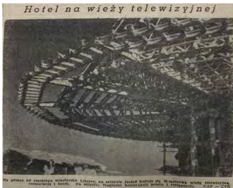
OBR. 16. DENÍK TRYBUNA LUDU , 26. BŘEZNA 1968, TITULEK SNÍMKU: „HOTEL NA TELEVIZNÍM VYSÍLAČI“, POPISEK SNÍMKU: „NA SEVER OD ČESKÉHO MĚSTEČKA LIBEREC NA VRCHOLKU JEŠTĚDU SE STAVÍ 76 METRŮ VYSOKÁ TELEVIZNÍ VĚŽ S RESTAURACÍ A HOTELEM. NA SNÍMKU: DETAIL KONSTRUKCE HOTELU A RESTAURACE.“
