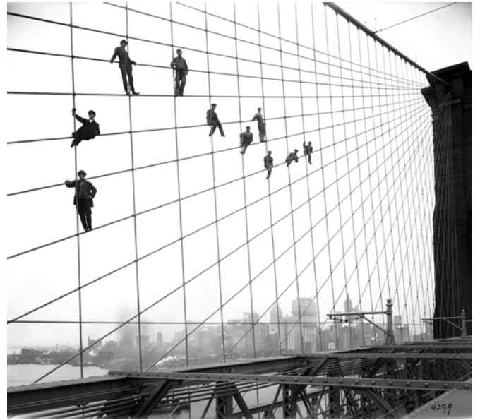
Eugene de Salignac, Dělníci montující kabely na Brooklynském mostě , 1914
