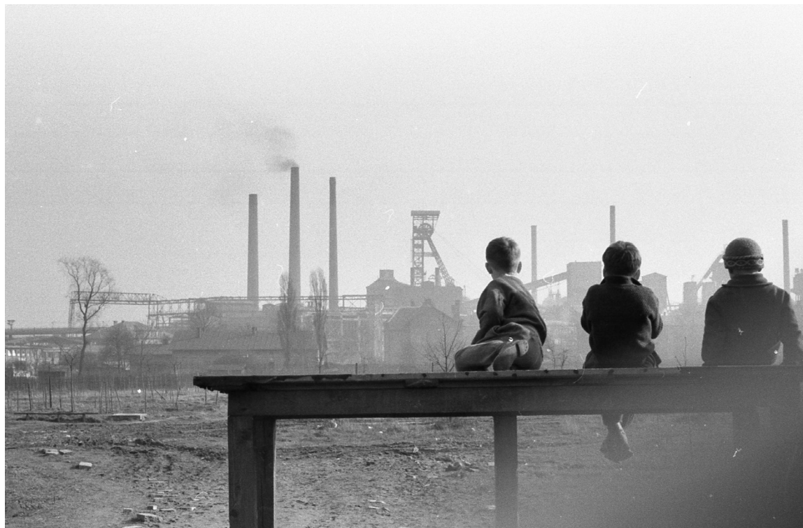
Gustav Aulehla: Ostrava , 1960. Zdroj: Marek Aulehla (archiv Gustava Aulehly).
