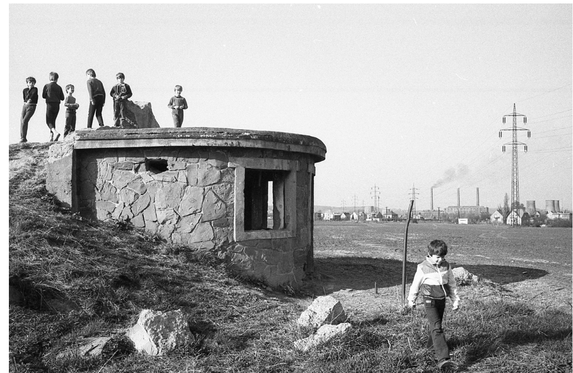
Gustav Aulehla: Ostrava-Třebovice , 1985. Zdroj: Marek Aulehla (archiv Gustava Aulehly).
