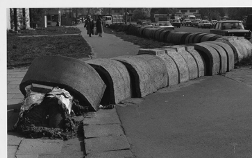
5. Widok ogólny na pierwszą część rurociągu
