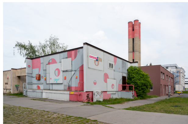
23/ Úprava trafostanice v ulici Dědinova od Jana Kalába.
