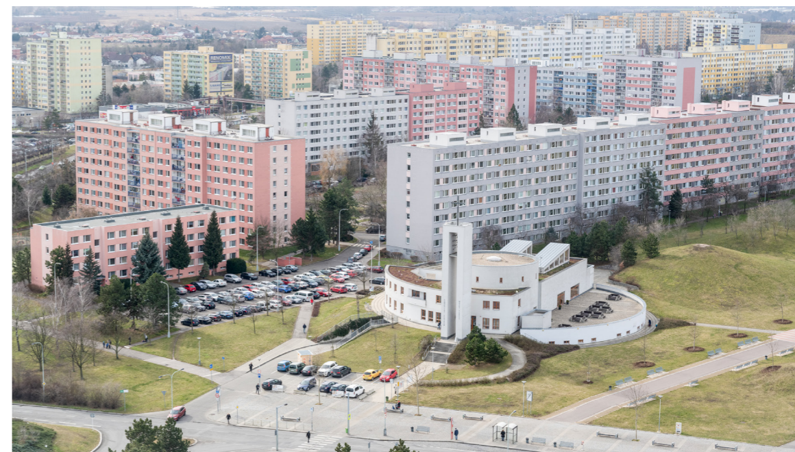
15/ Část Jižního Města – sídliště Opatov. V popředí komunitní centrum Matky Terezy.
