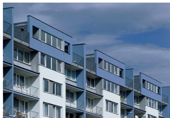
7 | Drexler Architekt: Nástavba malometrážních bytů v ul. Přestická, Praha 15.
