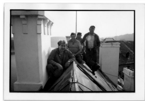
Řemeslníci během oprav střechy na zámku Orlický (foto, Zdeněk Stolbenko: 1988–91)
