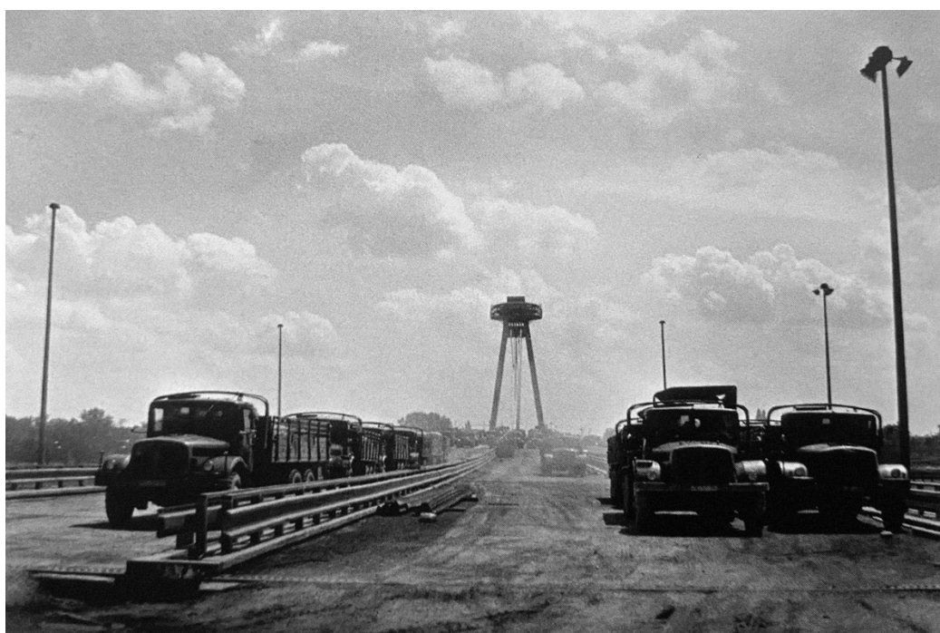
Rudolf Lendel: Výstavba mostu SNP, 1972
