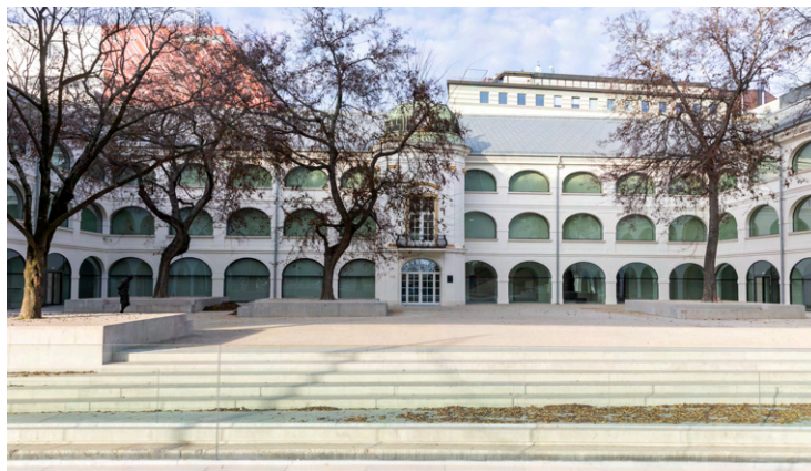
009: Miro Pochyba, Slovenská národná galéria po rekonštrukcii, nádvorie, 2022
