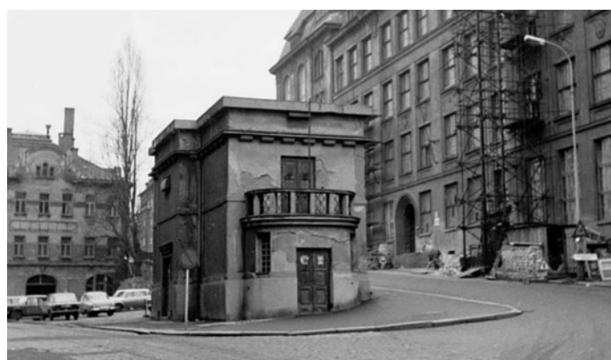
Trafostanice. Foto: Vlastimil Novotný, konec 60. let 20. století
