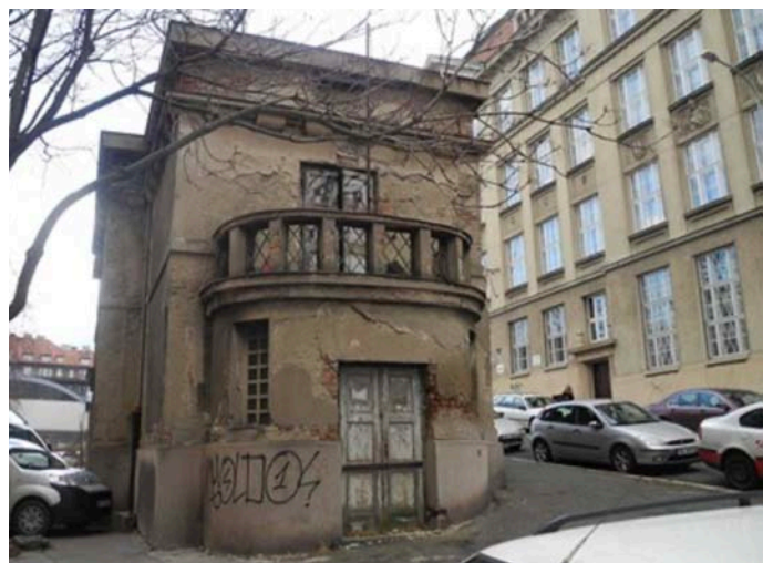
Trafostanice před rekonstrukcí. Foto: Jiří Peňás, 2012
