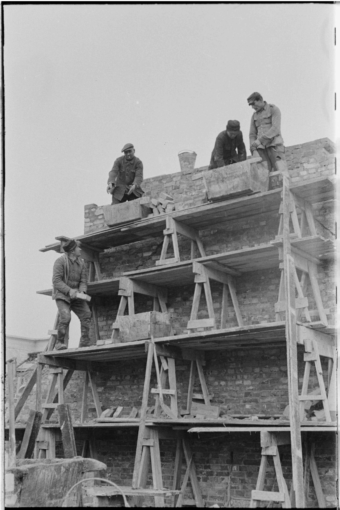
22. Stavba zdi, fotografie Alfreda Funkiewicze, 1948-1949, Muzeum Varšavy, č. j. AN 2963/F.
