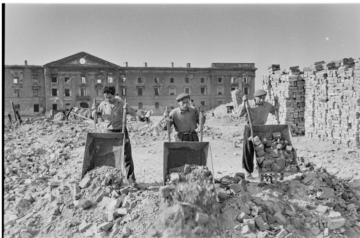
25. Skupina Židů pracujících na dekonstrukci bývalého ghetta, fotografie Alfreda Funkiewicze, 8. října 1947, Muzeum Varšavy, č. j. AN 3509/F.
