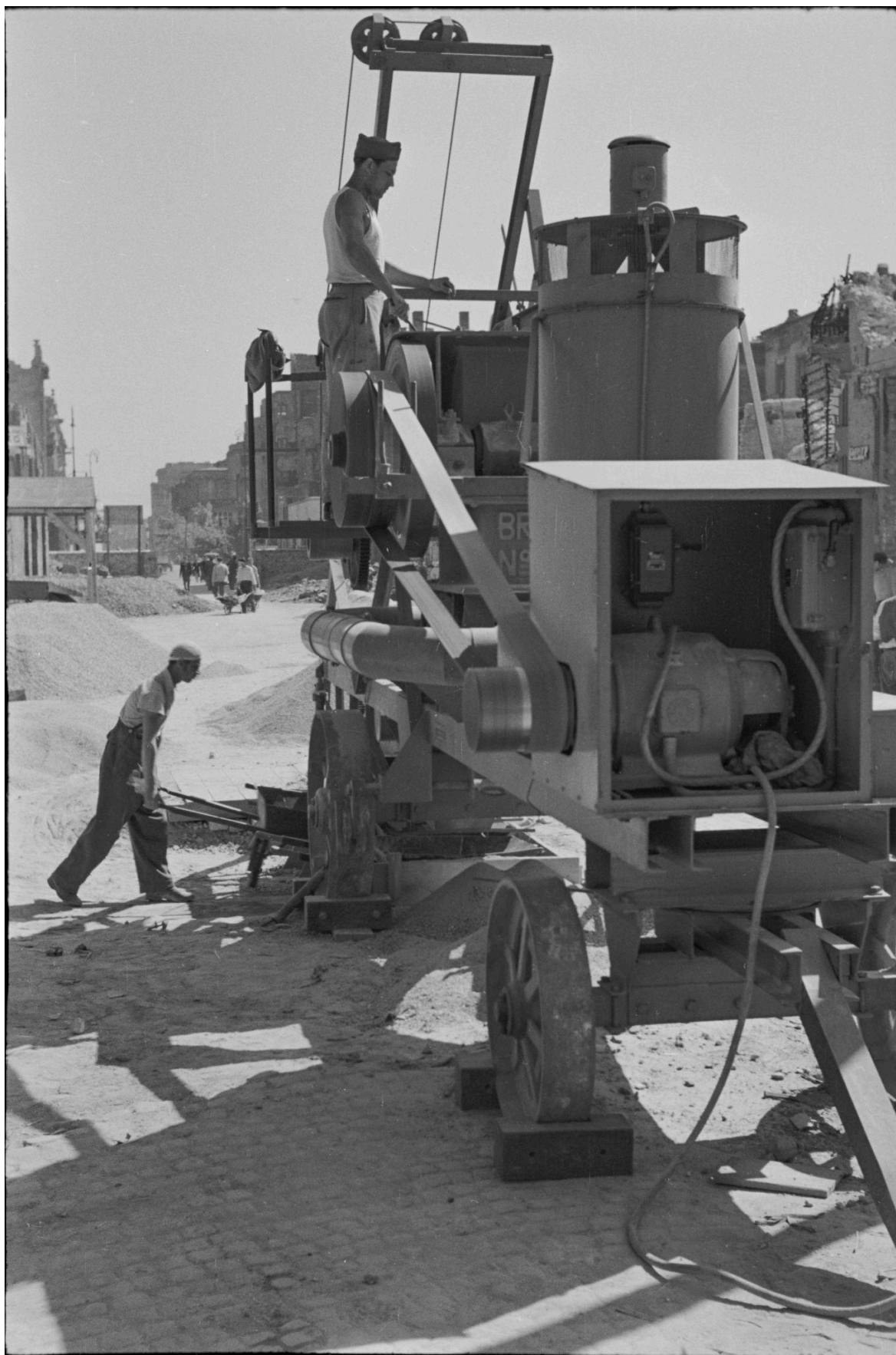
14. Stroj na zpracování suti na staveništi v ulici Sienna, fotografie Alfreda Funkiewicze, duben 1946, Muzeum Varšavy, č. j. AN 10463/F.
