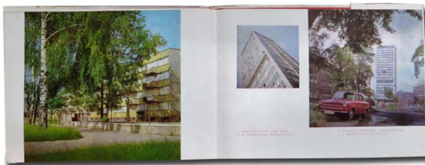
261: Pozemní stavby Ostrava | P13 | [1971]
