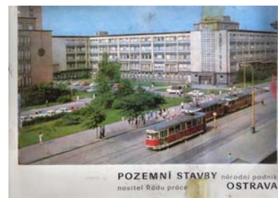
260: Pozemní stavby Ostrava | P13 | [1971]
