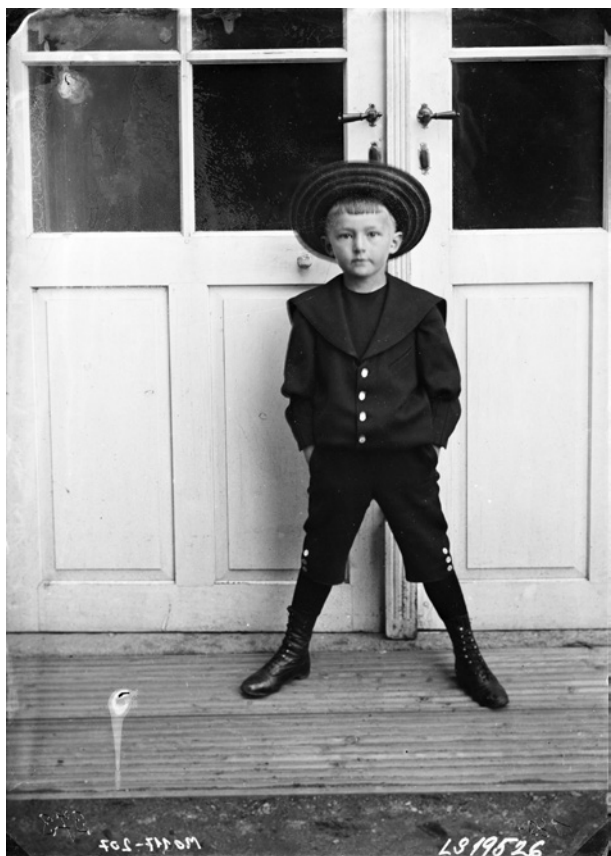
Chlapec pózující přede dveřmi zámku Moravec, 1894, skleněný negativ
