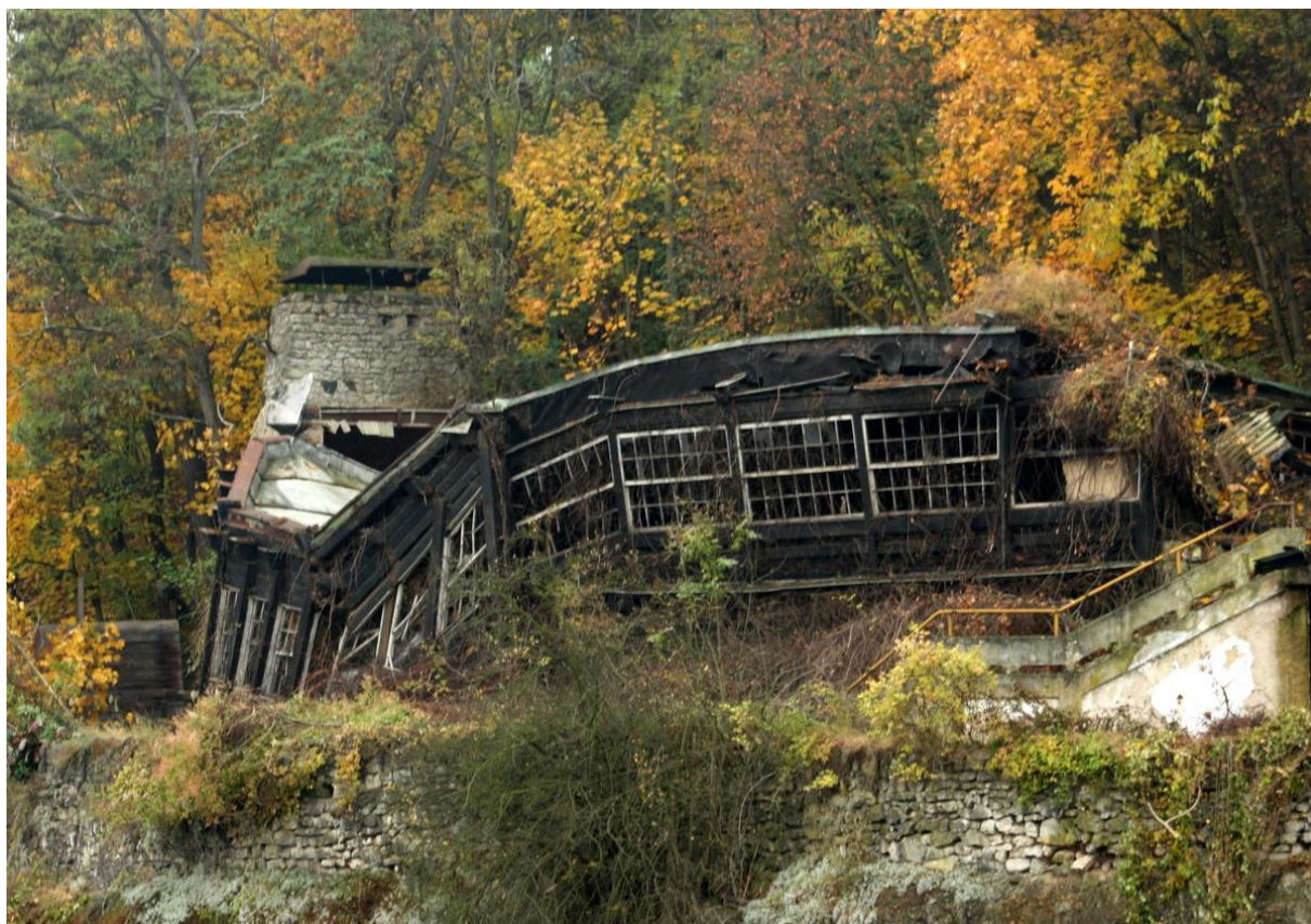
Obr. 88: Část vyhořelého Trilobit baru (po roce 2001). Zdroj: web Prazdnedomy.cz
