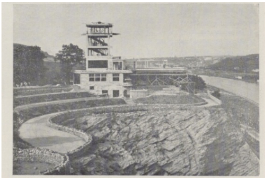
Obr. 29: Fotografie z procesu výstavby Teras. Reprodukce z publikace Dva- cet let Lucerny: 1909-1929
