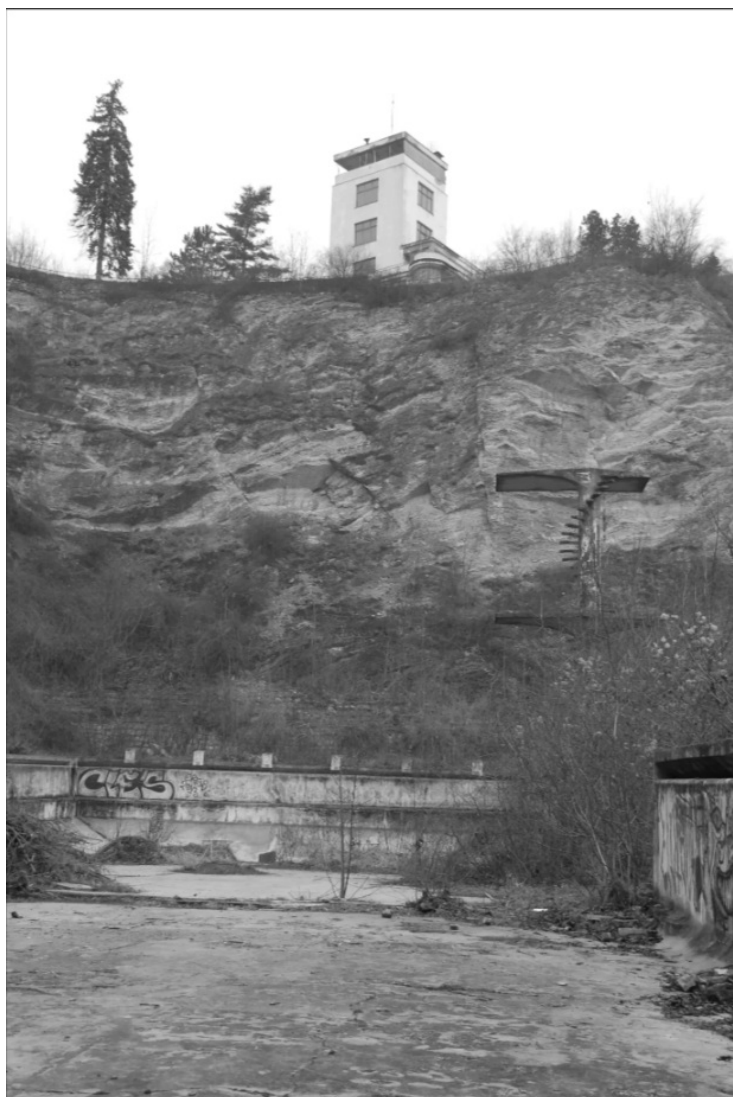
Obr. 90: Pohled na Terasy z bývalého bazénu, celý areál v dezolátním stavu (nedatováno). Zdroj: web Urbex.fans
