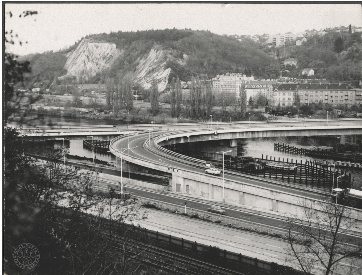
Obr. 87: Nově postavený Barrandovský most z Barrandovské skály, rok 1984. Autor: Michal Doležal. Zdroj: Archiv hl. m. Prahy
