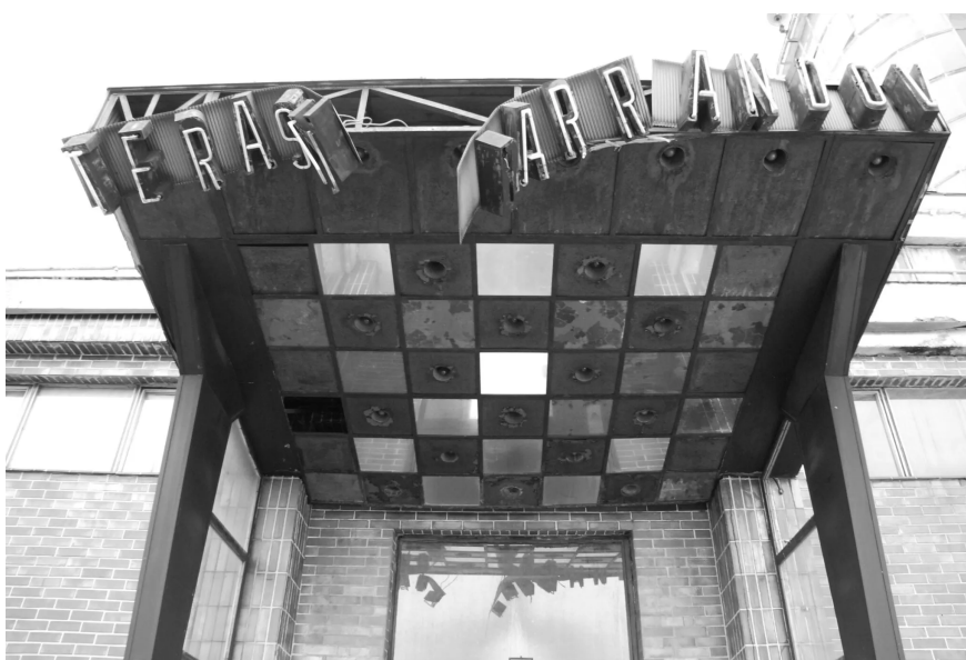
Obr. 91: Detail vchodu chátrající budovy restaurace (nedatováno). Zdroj: web Urbex.fans
