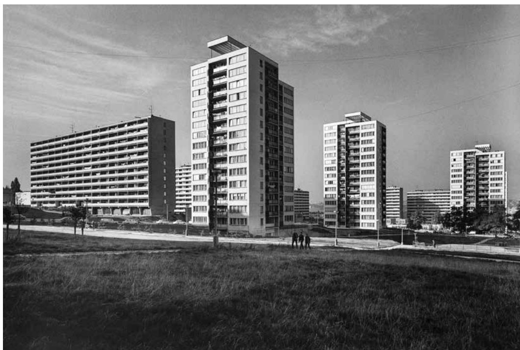
Zdeněk Voženílek - nové sídliště Krč
