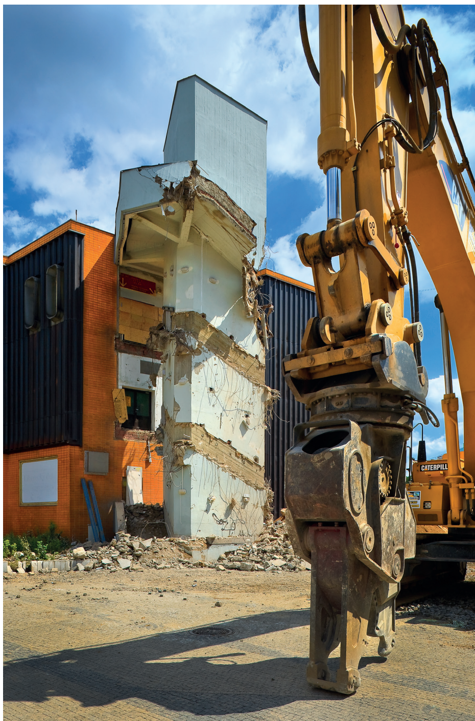
00 Ještěd_demolice_autor Jiří Jiroutek
