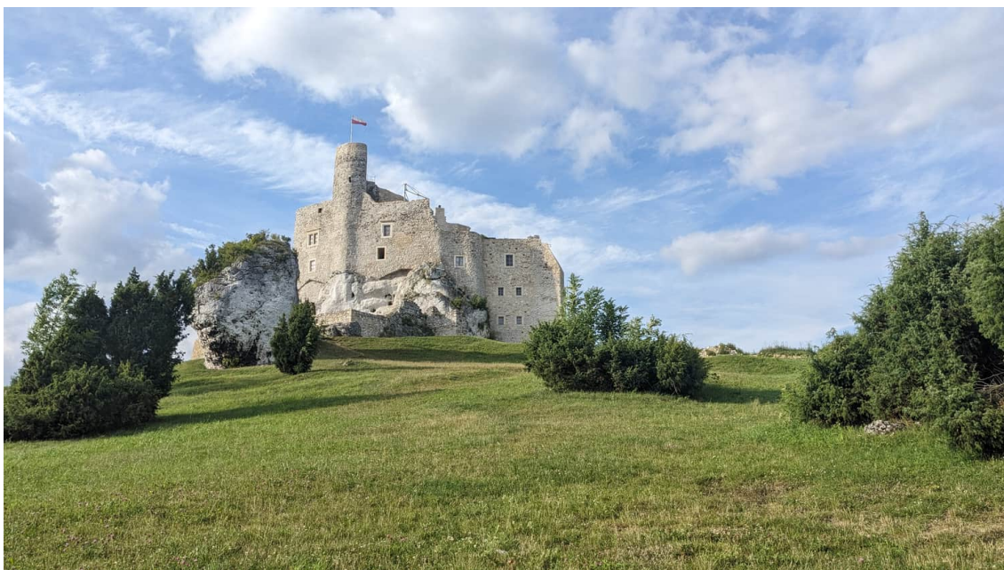
Hrad v Mirowě [online]. Dostupné z: https://www.trasadlabobasa.pl/tab/miejsce/zamek_mirow_zwiedzanie_historia_i_ciekawostki/471
