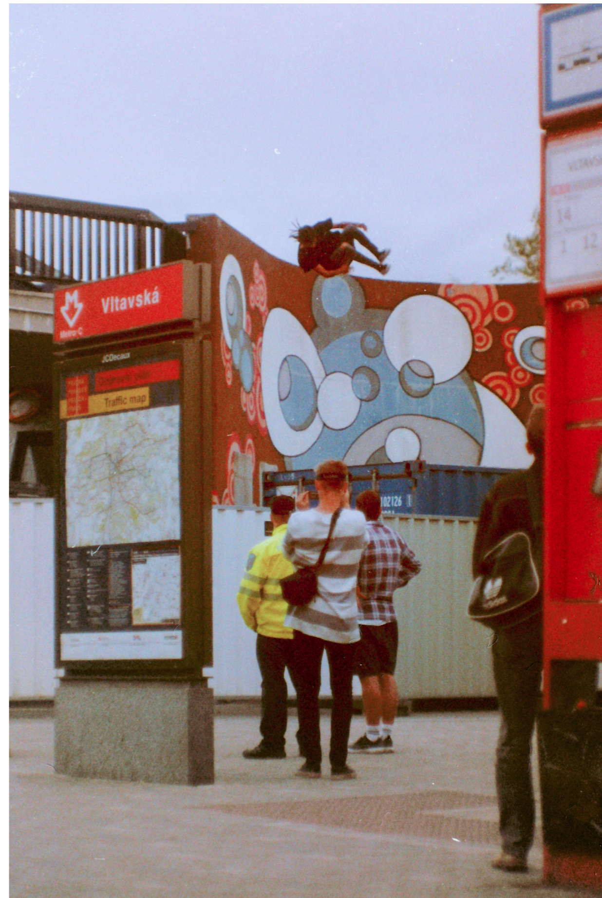
David Dovala skákající sideflip na stavební kontejner dělníků, kteří demolují Vltavskou, fotografie Vojtěch Drs
