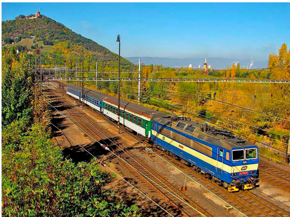
Stanislav Štýs: Přeložka železniční tratě v úseku Chomutov – Teplice trasovaná po vnitřní výsypce (2011)
