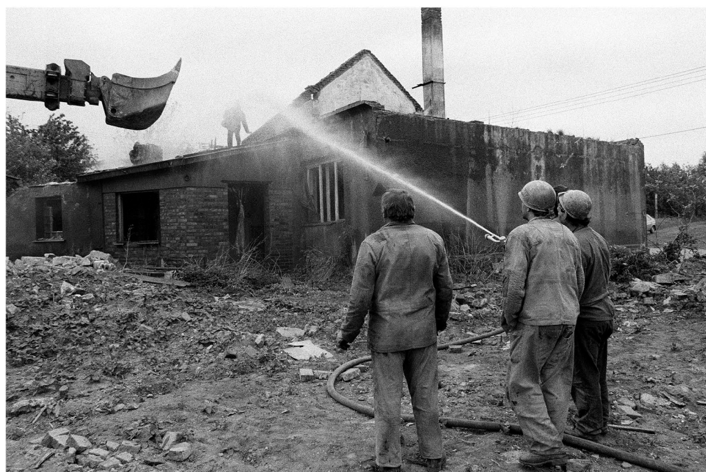
Ibra Ibrahimovič: Libkovice – Zdař Bůh – ...za pár minut shodili dělníci bagrem střechu domu v Příčné ulici i s Petrem Vozákem, Libkovice (1993)
