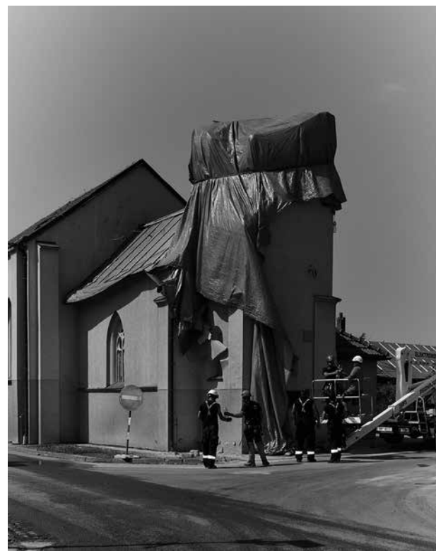
Obr. 55—56: Dokumentace obce Hrušky zničené tornádem, 2021.
