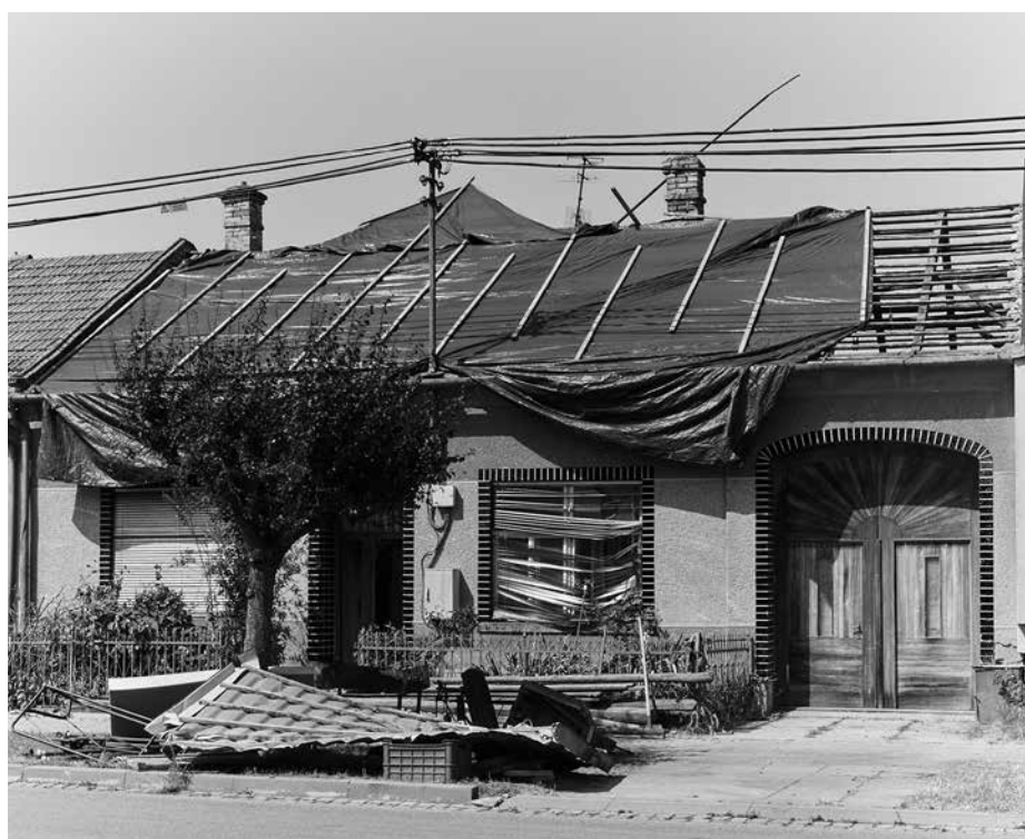
Obr. 54: Dokumentace obce Hrušky zničené tornádem, 2021.
