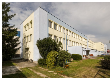
Obr . 24 — Budova školy v Kněžskodvorské ulici 33/A, někdejší administrativní sídlo oboru Fotograf. Foto: autor práce.
