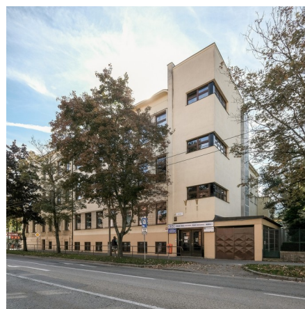
Obr . 25 — Budova Střední školy obchodní, Husova 9, pod níž obor Fotograf přešel po sloučení škol roku 2017. Foto: autor práce.
