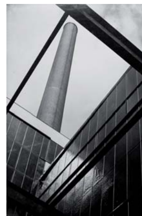
48 Jaromír Funke, Elektrárna ESSO v Kolíně , 1932
