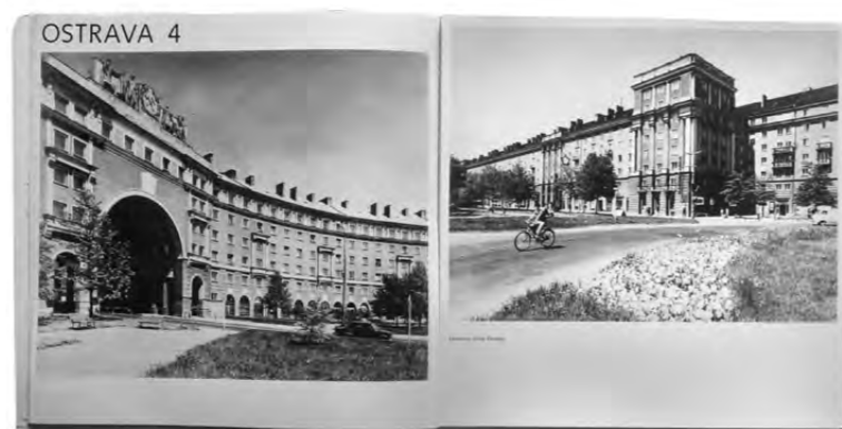
520: Ostrava: Přestavba a výstavba města | asi 1980 | P095
