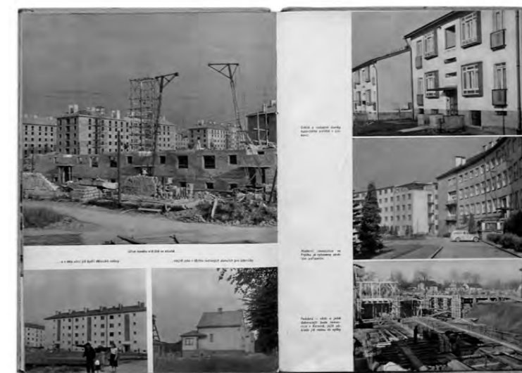
445: Na stavbách Ostravska | 1953
