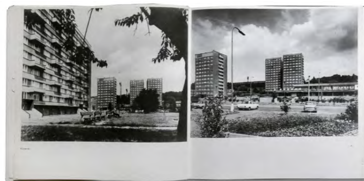
521: Ostrava: Přestavba a výstavba města | asi 1980 | P095
