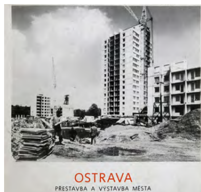
519: Ostrava: Přestavba a výstavba města | asi 1980 | P095
