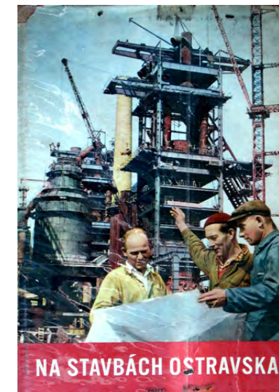
443: Na stavbách Ostravska | 1953
