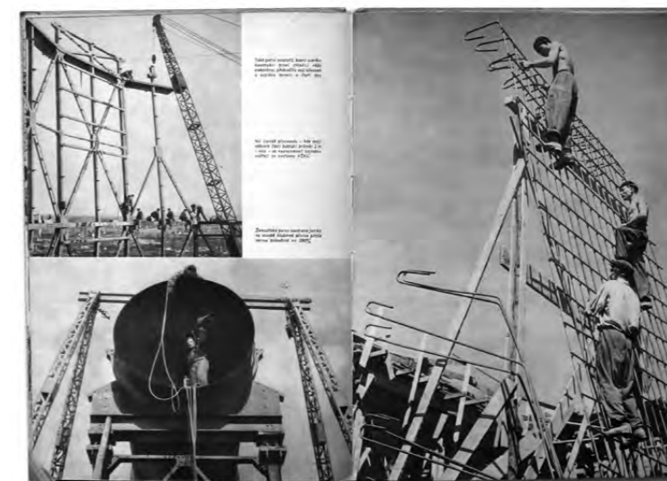
444: Na stavbách Ostravska | 1953
