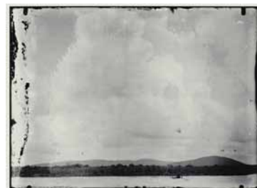
Koroze na okraji daguerrotypií je často způsobena špatně provedenou adjustací.
