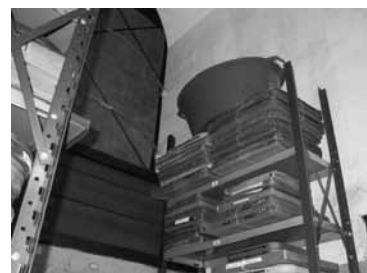
Zatékající voda představuje obrovské nebezpečí pro sbírky a je nutné ji co nejdříve odstranit.
