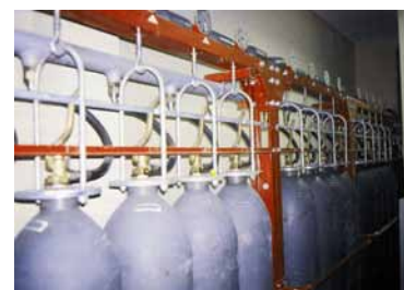
Hasící systém se zásobním CO 2
