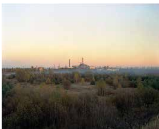
Pohled na elektrárnu Černobyl v roce 2001
