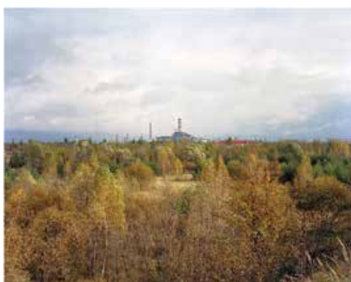
Pohled na elektrárnu Černobyl v roce 2004
