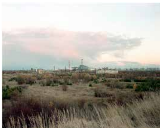
Pohled na elektrárnu Černobyl v roce 1998
