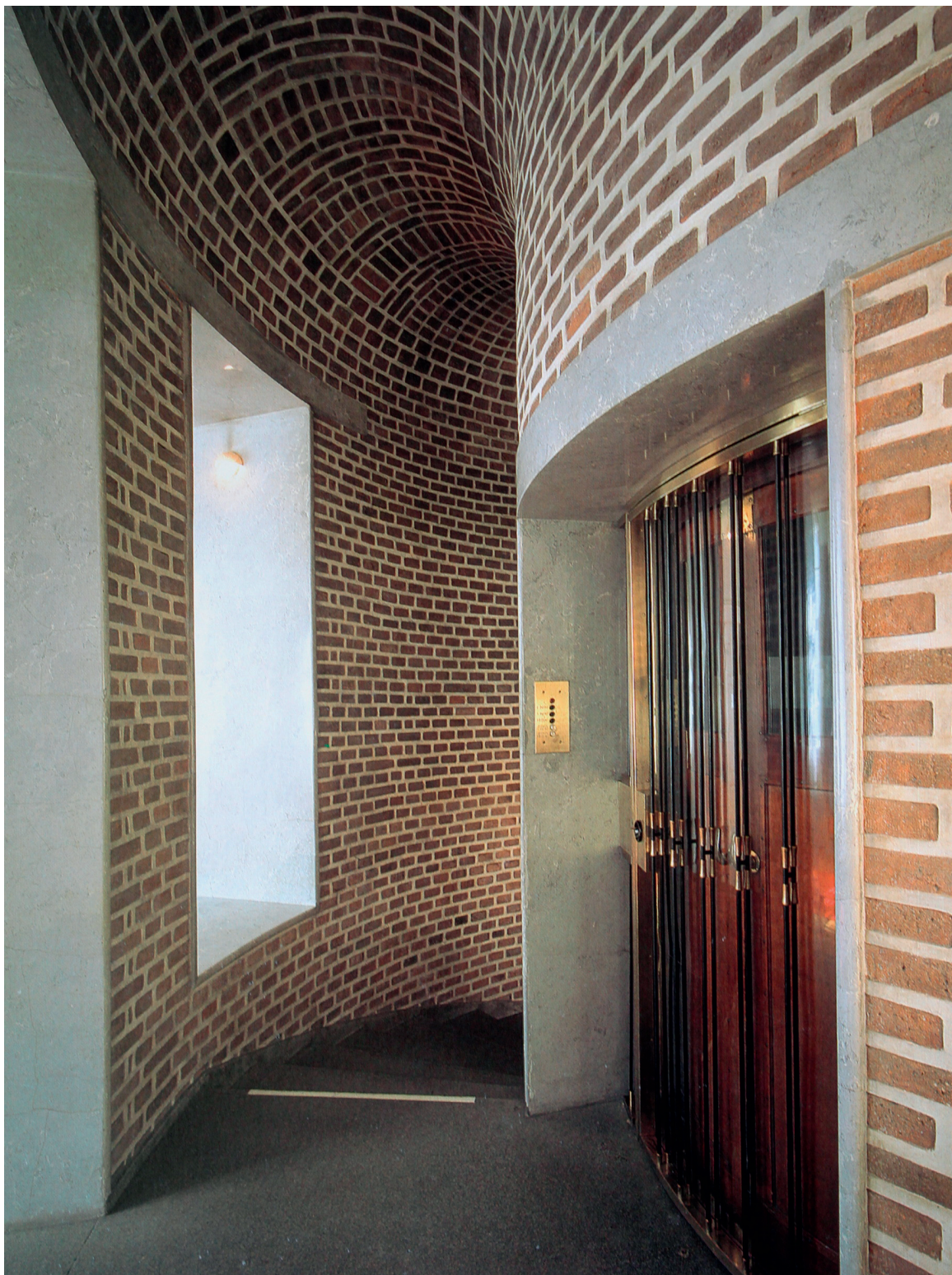
schodišťová věž s prezidentským výtahem v Novém paláci, Pavel Štecha, Praha
