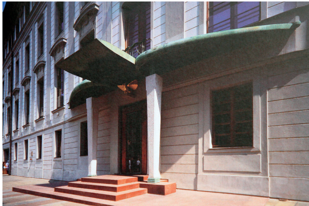
nový vstup do Kanceláře prezidenta republiky z II. Nádvoří, Pavel Štecha, Praha
