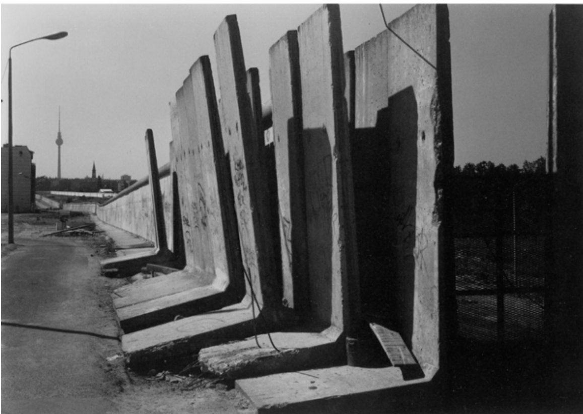
An der Justbrücke, 13.8.1990
