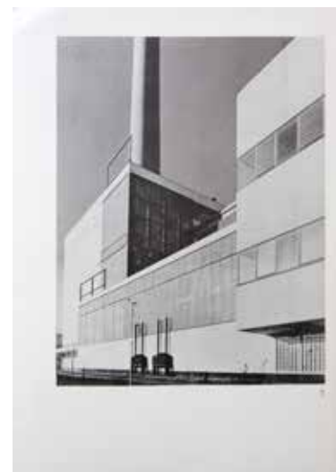
5 Jindřich Koch, elektrárna ESSO v Kolíně – projekt J. Fragnera, 1933, ukázka z publikace Jindřich Koch, Nakladatelství SGŠ, archiv Miloslavy Rupešové
