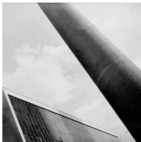
120 Eugen Wiškovský, Elektrárna ESSO v Kolíně , 1932, archiv MA
