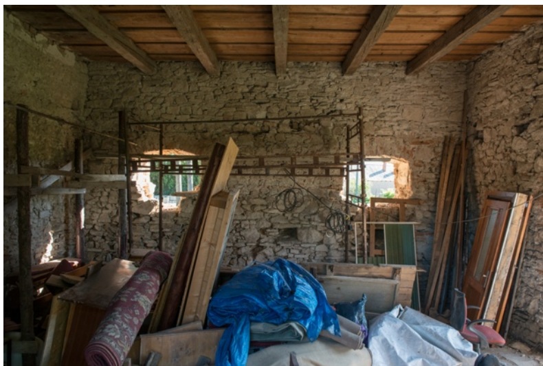
Obr.92 Anton Baša rekonštrukcia západnej časti farskej budovy júl, 2018
