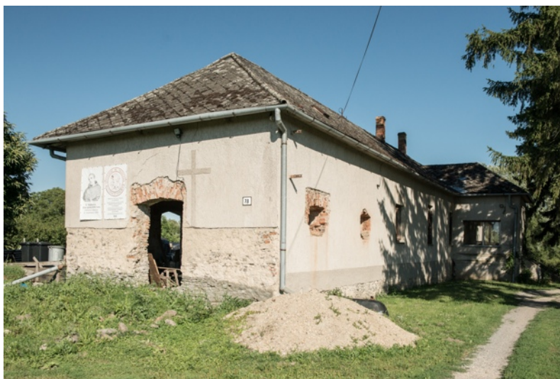
Obr.93 Anton Baša rekonštrukcia západnej časti farskej budovy júl, 2018
