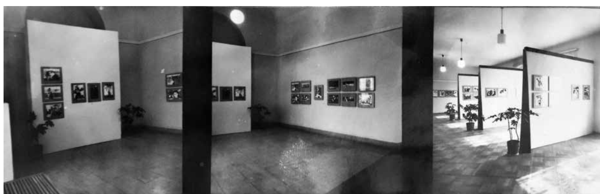
Instalace výstavy v roce 1969
