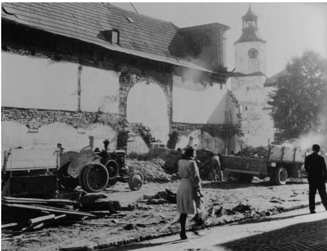
Demolice staré zástavby v 50. a 60. letech v Rýmařově. (fotografie č. 76)
