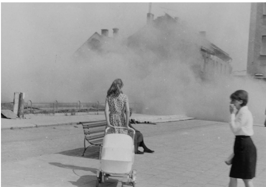
Demolice staré zástavby v 50. a 60. letech v Rýmařově. (fotografie č. 78)
