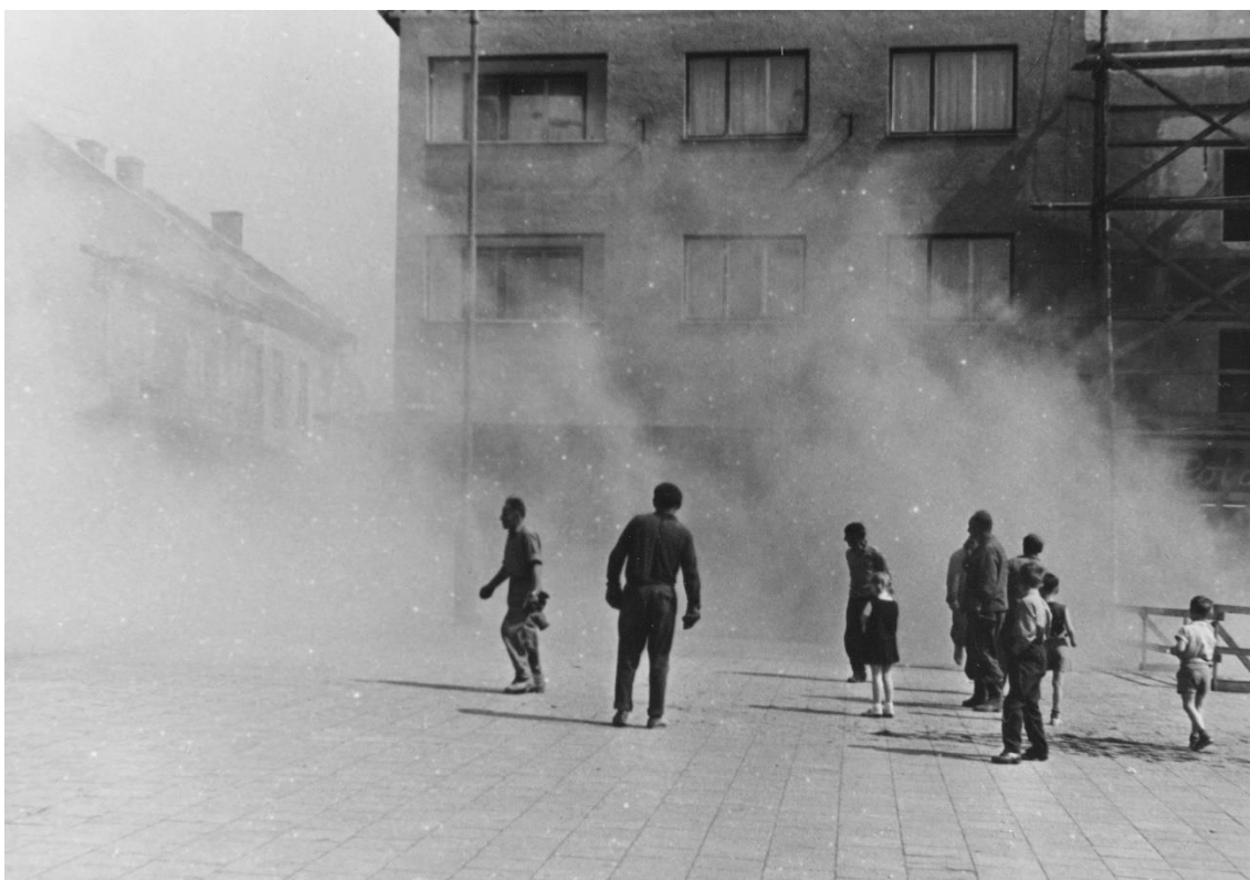
Demolice staré zástavby v 50. a 60. letech v Rýmařově. (fotografie č. 77)
