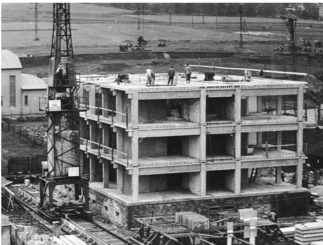
ČTK, stavba prvního panelového domu v Ďáblicích
