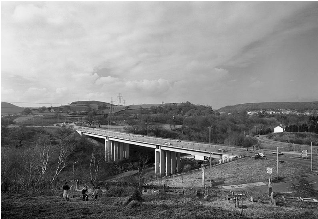
Fotografie č. 1 John Davies, Quakers Yard Bridge, Merthyr Tidfil, 1996.
