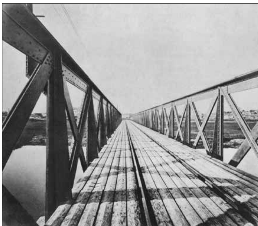
8. Fotografie konstrukce železničního mostu přes Labe. J. Löwy nebo jim pověřený fotograf, 1871 8
