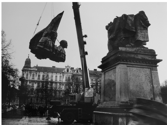
obr. 61 demontáž sousoší (archiv autora)
