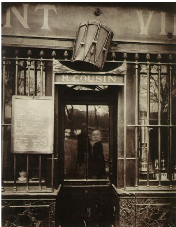
Eugene Atget, Au Tambour, 63 quai de la Tournelle, 1908
