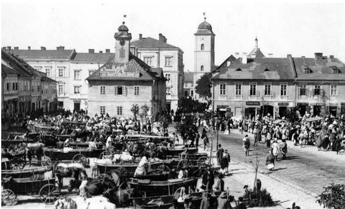
Obrázek 22: Radnice v den trhu (budova radnice před přestavbou), před rokem 1895
