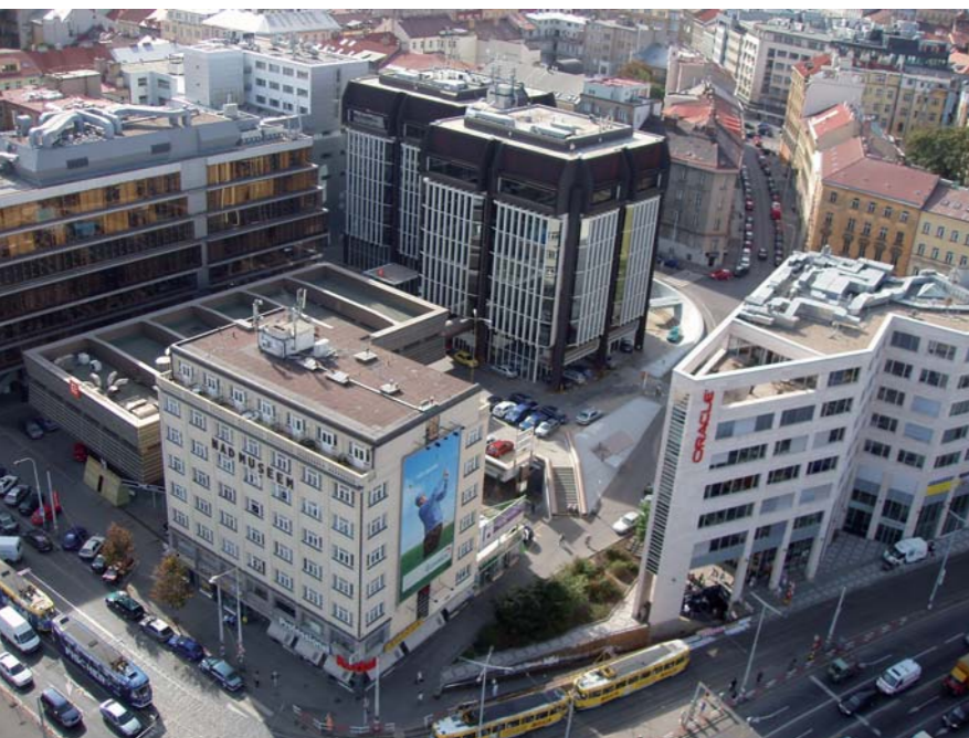
Areál dispečinku tranzitního plynovodu na Vinohradech (V. Aulický, J. Eisenreich, J. Fišer, I. Loos, J. Malátek), 1978. Autor snímku Jiří Pištěk. Z archivu V. Aulického.
